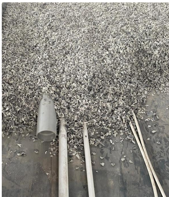
Obr. 2 Využití podsypu EKOSTAB 4/8 jako vyrovnávací vrstvy a ochrany instalací
